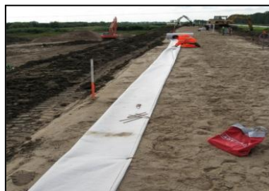
Geotextiel met geïntegreerde glasfiber
