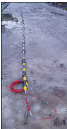
Inmeten van mantelbuizen voor GEWI-palen
