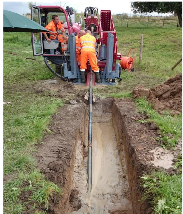
Aanbrengen fibernetels met gestuurde boring
