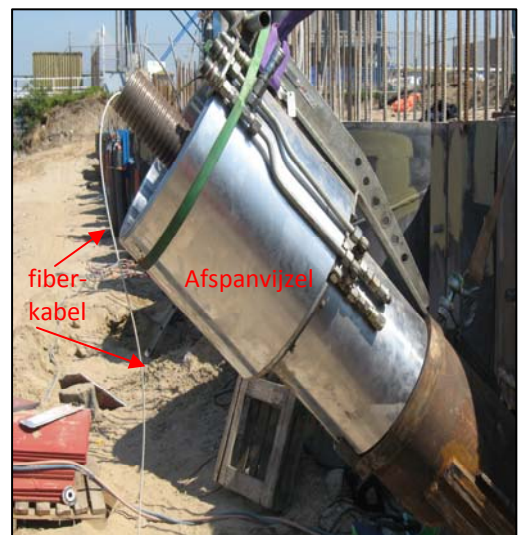
Afspannen van een groutanker
