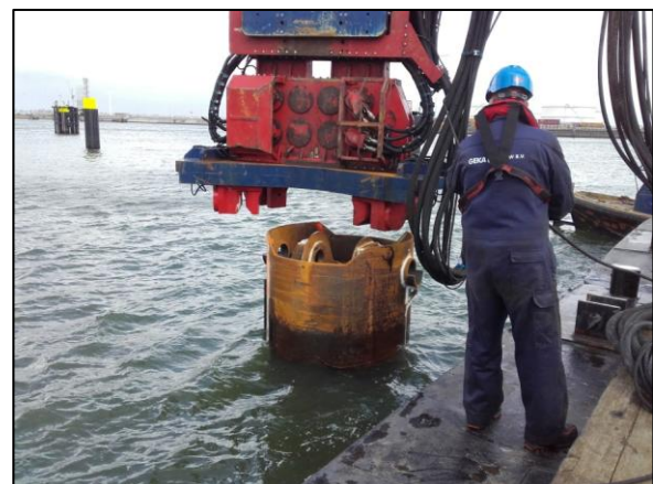
Intrillen van de buispaal
