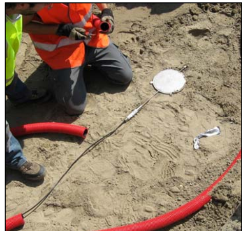
Plaatsing van een total pressure cell
