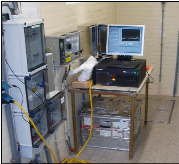
DTS metingen op een HV schakelstation
